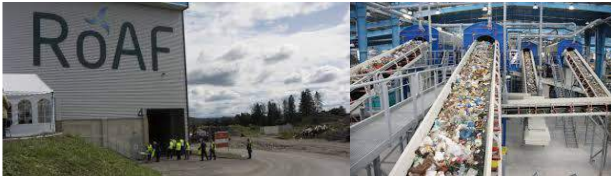
Figura 4.12 – Instalação de tratamento de resíduos urbanos RoAF (Fonte: www.greenvisits.no )
